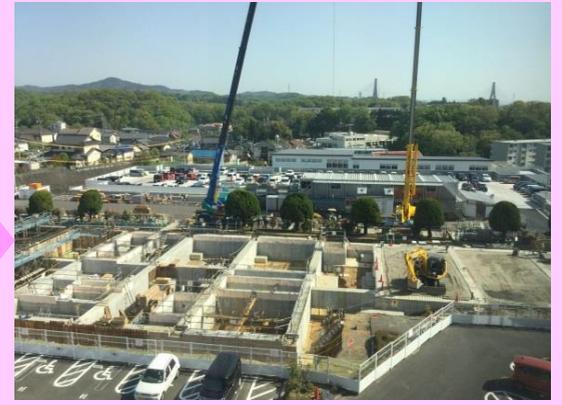
③4月下旬、基礎コンクリート打設、埋戻し工事中
